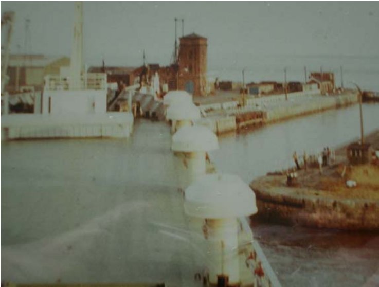
Ansteuerung der Schleuse vom Alexandriadock zum Humber-River
